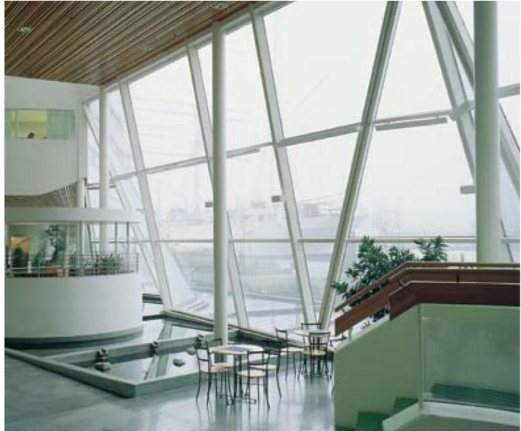
Thermopius schützt vor kalter Zugluft. Das Wärmestrahlergehäuse wirkt sehr diskret, da es weit oben an einem Träger befestigt ist.
