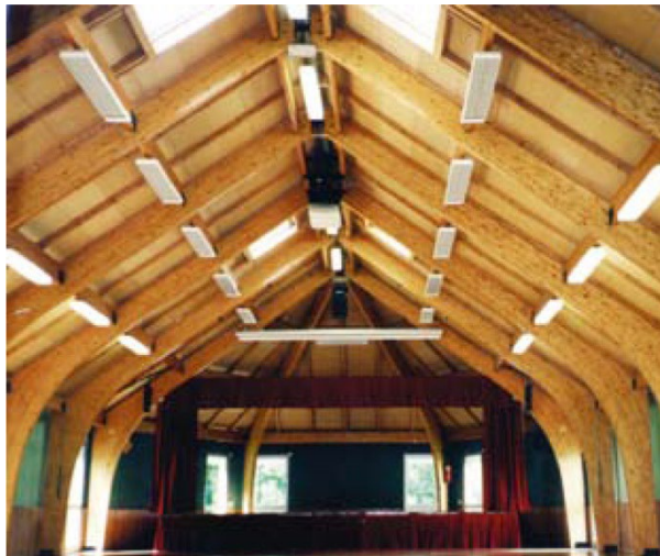
EZ200 gibt direkt Wärme ab, ein Vorheizen ist nicht nötig. Dadurch eignet sich das Gerät besonders für Gebäude, die nur in unregelmäßigen Abständen genutzt werden.
