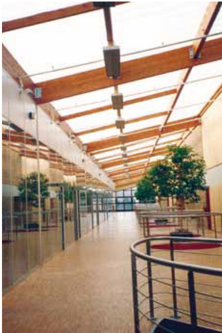
Flure sind sehr schwer zu beheizen, aber der an der Decke montierte EZ100 heizt dort, wo die Wärme benötigt wird.
